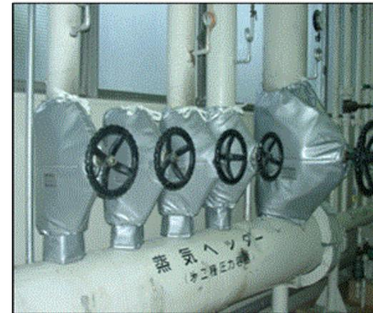
図1 蒸気ヘッダー部バルブの保温状況
